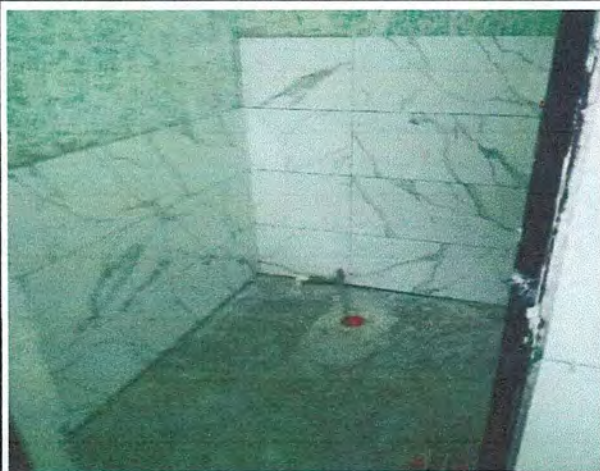
Foto 5: Area de donde se esta realiznando el mantenimiento y cambio de sanitarios
