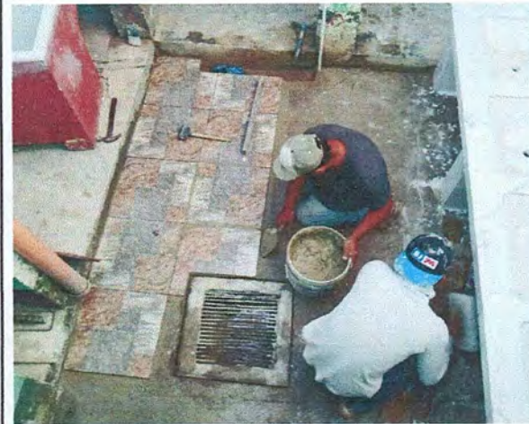
Foto 4: Area de donde se esta realizando el mantenimiento y cambio de piso en el area de lavamanos.
