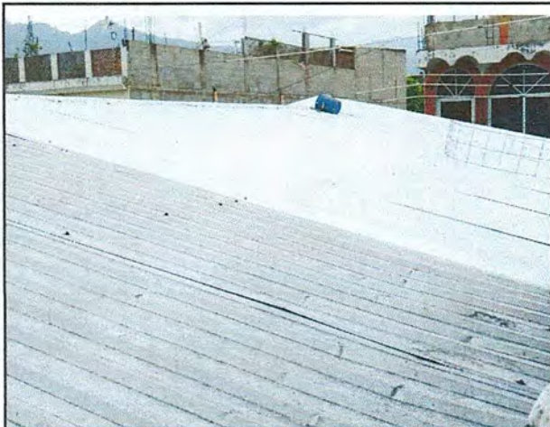
Foto 1: Area de donde se esta realizando el mantenimiento y cambio de lamina.
